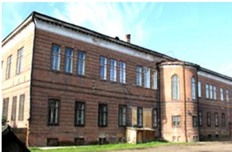
Декор фасадов выдержан в строгих рациональных формах. По верху здания проходит профилированный карниз с модульонами и широкий оштукатуренный фриз; по углам установлены водосточные трубы с воронками, украшенными просечными железными деталями. Под окнами второго этажа проходит тройная междуэтажная раскреповка поясками, обводящая все здание. Цоколь выделен гладко затертыми швами кладки. Кирпичные стены оформлены рустом в двух этажах с выделением гладкого междуэтажного пояса.
