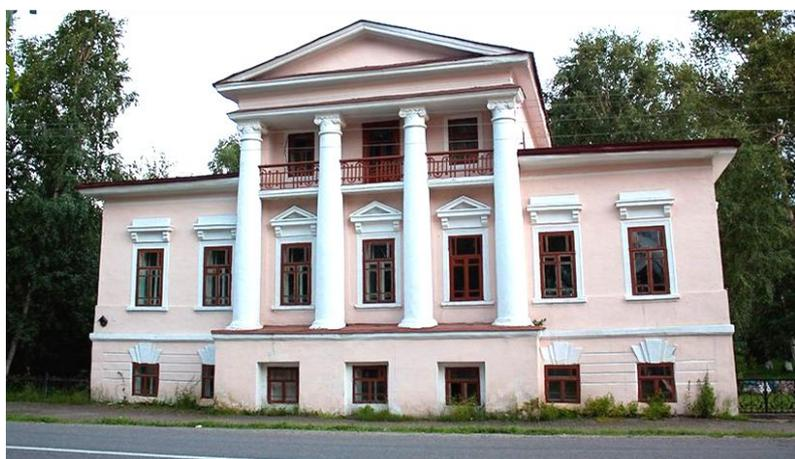
Восточный боковой пятиконный фасад удлинен дворовой пристройкой в три окна. Здание крыто железной вальмовой кровлей, мезонин третьего яруса – двускатной. Средняя трехосевая часть фасада оформлена четырехколонным портиком: колонны с ионическими капителями поставлены на
